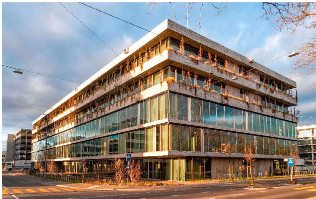
Der Neubau «Belo Horizonte» des Schweizerischen Tropen- und Public Health-Instituts © Joachim Pelikan
