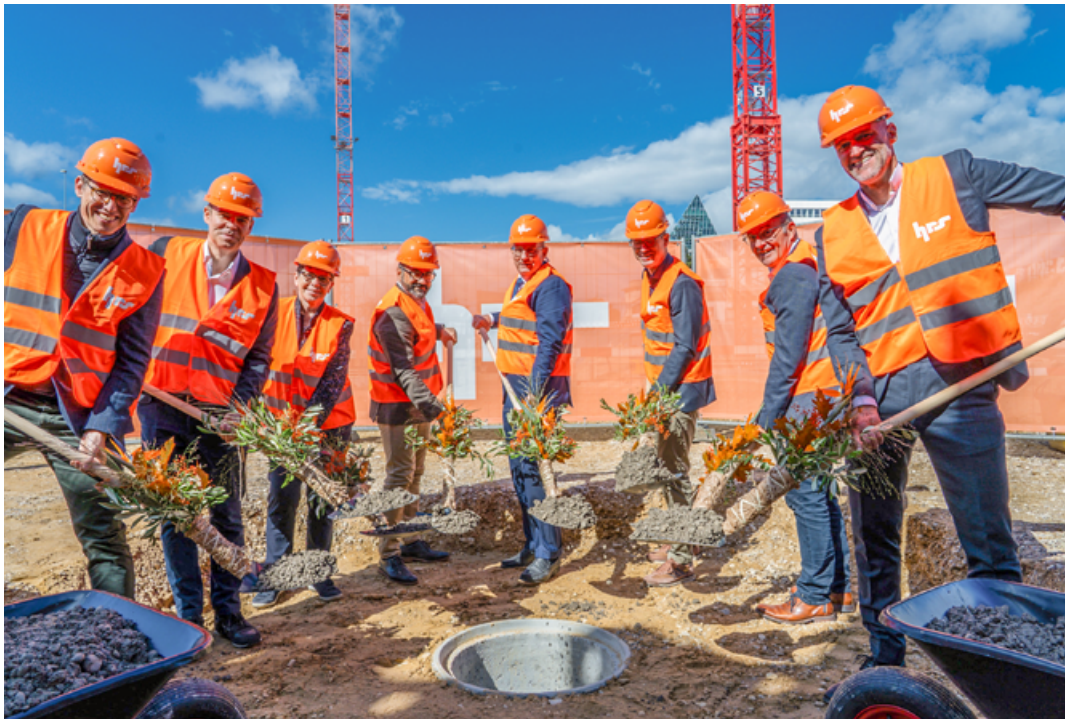
Mit der feierlichen Grundsteinlegung hat das Wohn- und Gewerbequartier «am Schänzli» in Muttenz einen weiteren wichtigen Meilenstein erreicht. (Quelle: am-schaenzli.ch )
